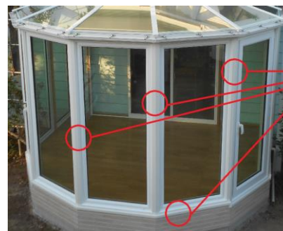
軸組(柱) (下枠): アルミ フロント材
