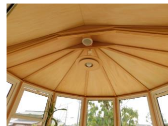
遮熱・断熱仕様天井(シナ合板)
