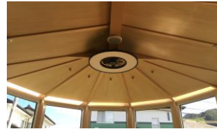
遮熱・断熱仕様天井(シナ合板)
